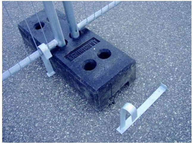
Aushebesicherung für Mobilzaun
